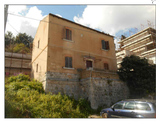
III Casa Cantoniera
